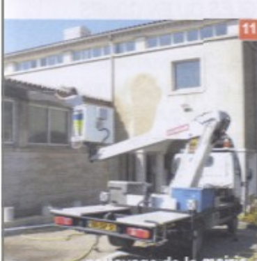
nettoyage de la mairie
