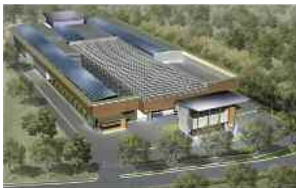
USINE DE TRI-COMPOST DU BROC
