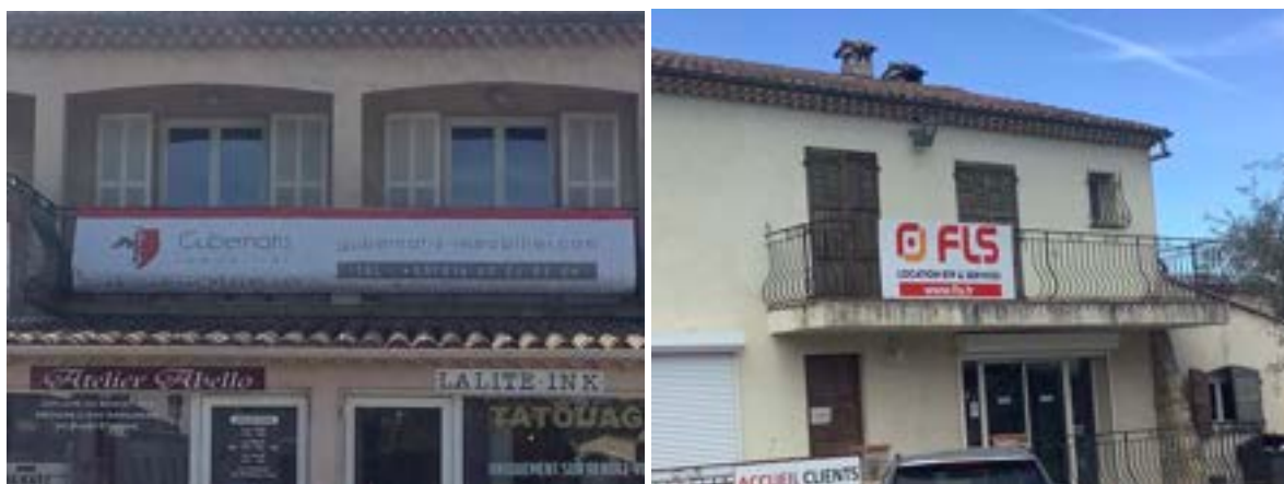
Enseignes sur garde-corps de balcon, La Roquette-sur-Siagne, avril 2023
