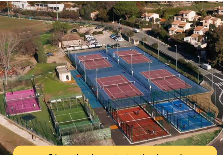
Rénovation des quatre terrains de tennis et création de deux terrains de padel
